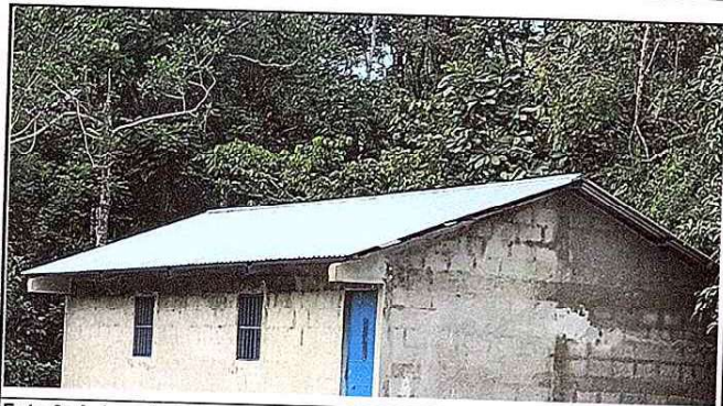
Foto 3: Aula antigua con techo terminada, con puertas y ventanas puestos
