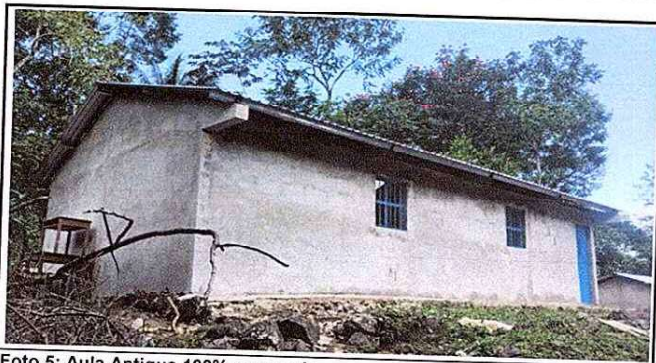
Foto 5: Aula Antigua 100% remozada
